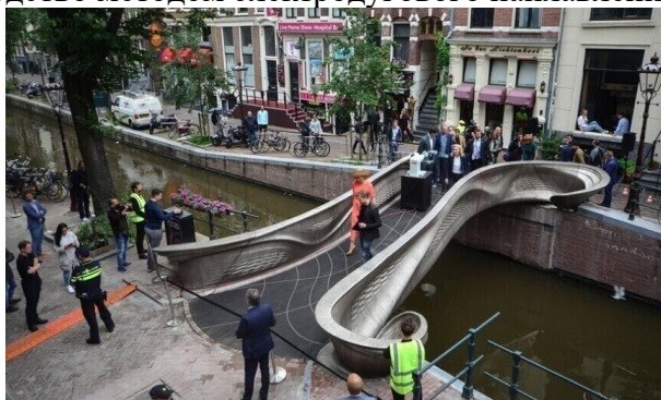
Рисунок 9 - 3D-печатный стальной мост
