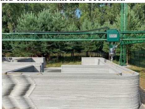
Рисунок 3 - 3D-печать опалубки на строительном 3D-принтере ярославской компании «АМТ»
